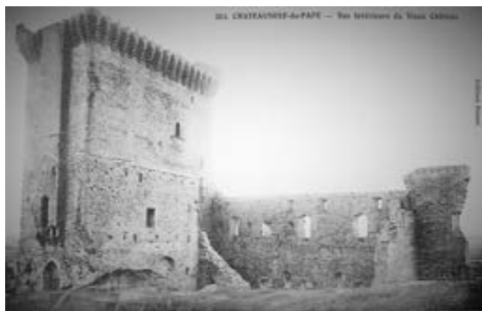
Vue intérieure du château avant 1944
